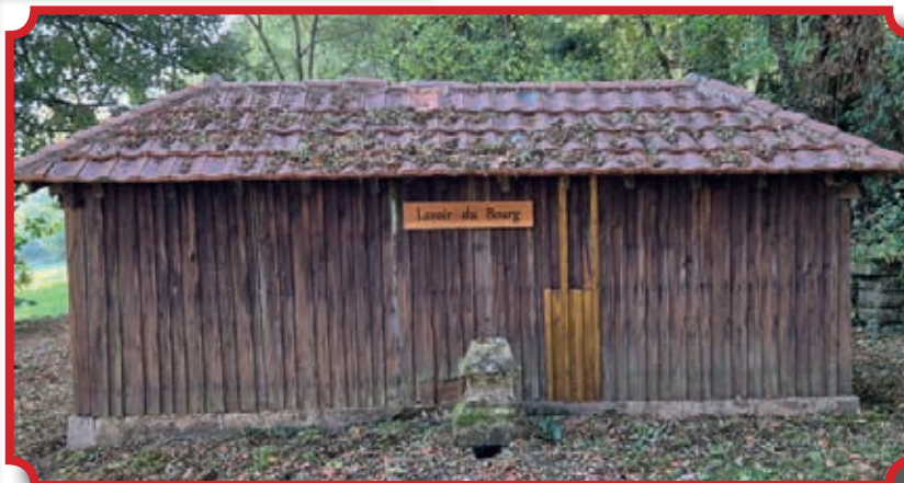
Après nettoyage et démoussage
